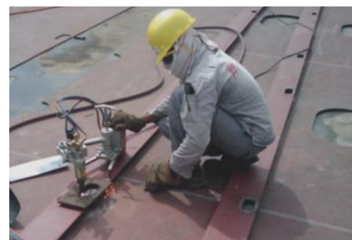
Esempio di applicazione in cantiere navale
